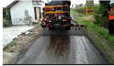
Gambar 9 Penyemprotan Aspal Lapis Perekat Mesin Penyemprot Aspal Truck
