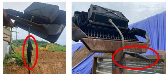
**Gambar 5** Sambungan Kabel Konvensional dengan Menggunakan Selotip Sebagai Pelindung (Sumber: Putra Sinaga, 2024)
