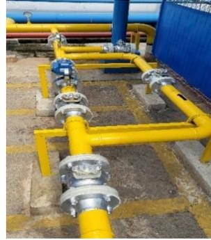
Gambar 8 Instalasi Interkoneksi Pipa Gas
