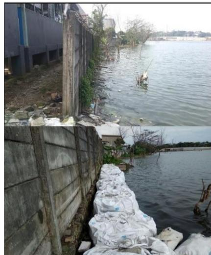
**Gambar 2** Kondisi Tahun 2017 Air Danau Sudah Bersentuhan dengan Pagar dan Ada Perkuatan Pagar dengan Menggunakan Semen Dalam *Jumbo Bag*
