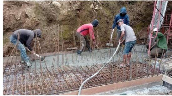
Gambar 3 Proses Pengecoran
