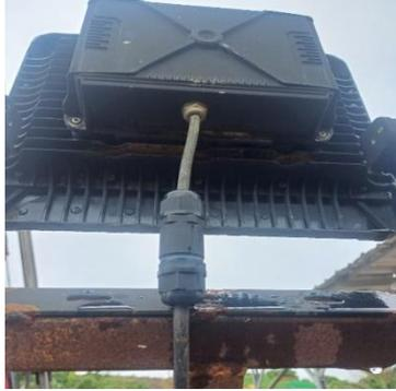
**Gambar 6** Sambungan kabel dengan *Connector Waterproof* (Sumber: Putra Sinaga, 2024)
