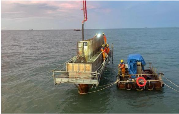
**Gambar 7** Persiapan Pekerjaan Pengecoran Pilecap Struktur Jetty
