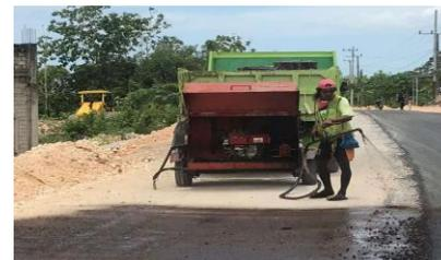
Gambar 11 Penyemprotan Aspal Lapis Perekat Mesin Penyemprot Aspal Portable
