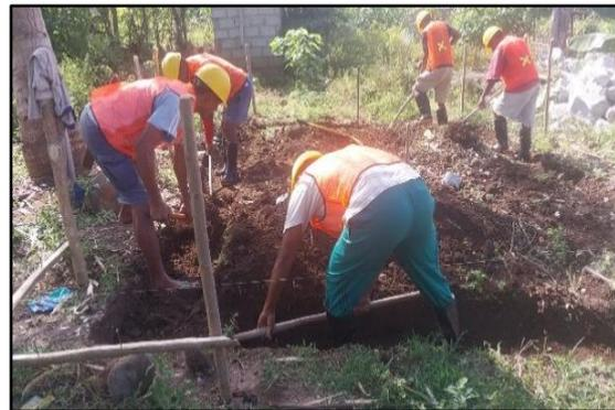
Gambar 2 Pekerjaan Galian Pondasi Bak Reservoir
