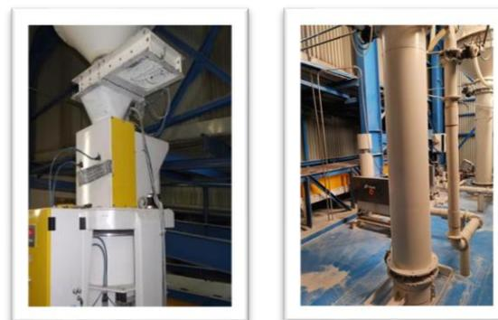
Gambar 7 Transfer dengan *Fluidizing System*
