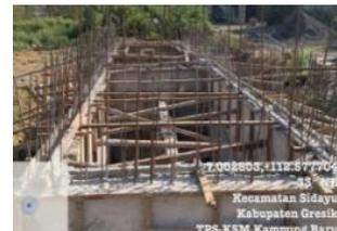
**Gambar 3** Konstruksi Pembangunan IPAL
