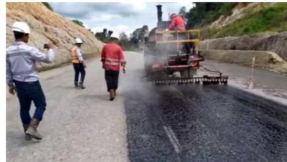
Gambar 10 Penyemprotan Aspal Lapis Resap Pengikat Mesin Penyemprot Aspal Truck
