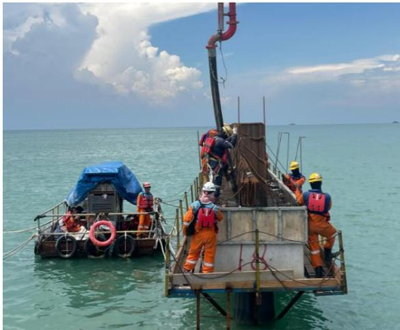
**Gambar 8** Proses Pekerjaan Pengecoran Pilecap Struktur Jetty
