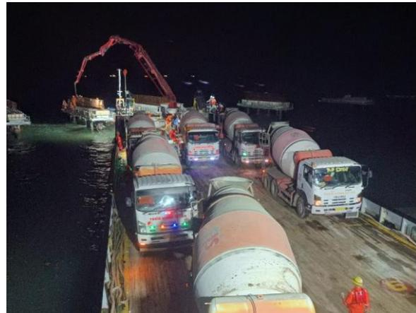
**Gambar 5** Penerapan Proses Pengecoran di Wilayah Laut Menggunakan Barge
