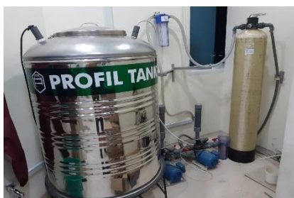
Gambar 2 Tandon produk RO dan pompa Demin
