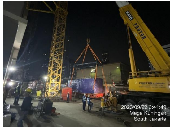
Gambar 11 Unloading dan Lifting Generator 1000KVA dari Truk Pengiriman Menuju Landing Stage
