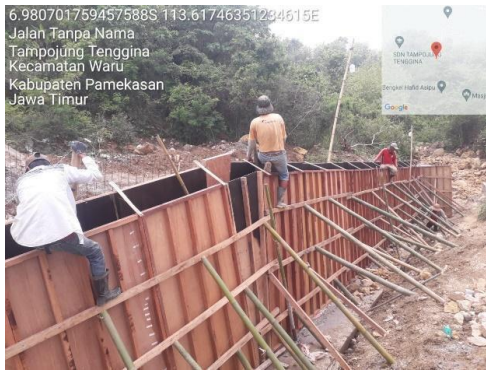
Gambar 5 Pekerjaan Bekisting
