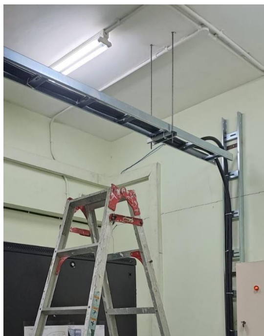
Gambar 2 Perapian kabel menggunakan cable ladder
