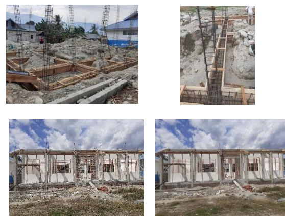
Gambar 14 Proses Pembangunan Gedung Laboratorium SPMN 11 Sidondo
