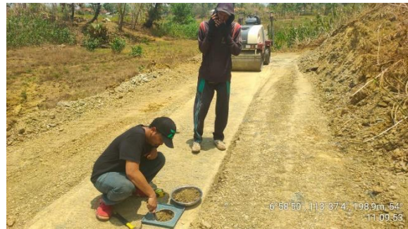
Gambar 3 Pekerjaan Uji Coba Timbunan
