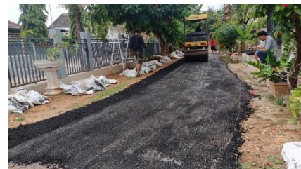
Gambar 2 Proses perbaikan PSU jalan di Perumahan Mutiara Harum Desa Kalimook
