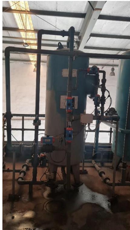
Gambar 6 Gambar Water softener dengan valve pneumatik
