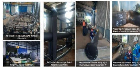
Gambar 4 Proses Fabrikasi Baja Di Workshop
