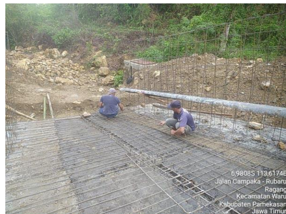
Gambar 6 Pekerjaan Penulangan
