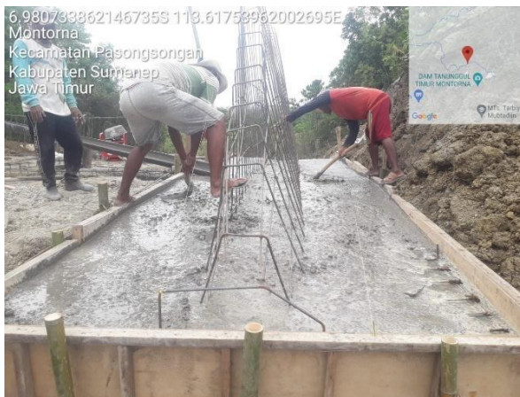
Gambar 4 Pekerjaan Beton K-175
