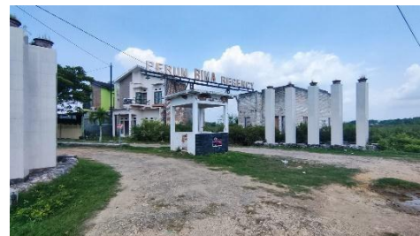
Gambar 3 Pintu gerbang / pintu masuk Perumahan Bima Regency
