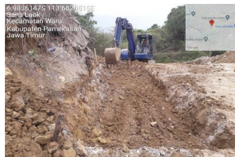
Gambar 2 Pekerjaan Galian Tanah Mekanis
