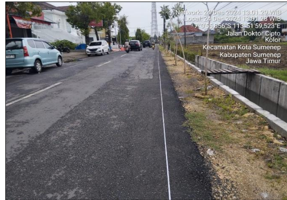
Gambar 3. Penghamparan Aspal Emulsi (CPHMA) pada Pekerjaan Peningkatan Saluran Drainase Perkotaan dan Lingkungan Jl. Dr. Cipto (Lanjutan)
