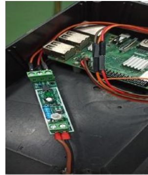
Gambar 3. Gambar Proses Implementasi Pemasangan Rangkaian Raspberry Pi 3B+ ke Optocoupler dan ke Phi Analyzer
