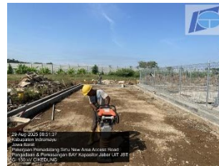
Gambar 4. Proses Pemadatan Sirtu
