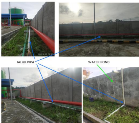
Gambar 11. Pemasangan Jalur Pipa
