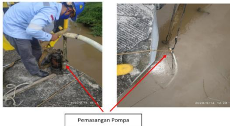
Gambar 10. Pemasangan Pompa
