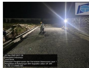
Gambar 5. Proses Pemadatan Base Course
