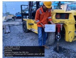
Gambar 6 Pengujian CBR Lapangan
