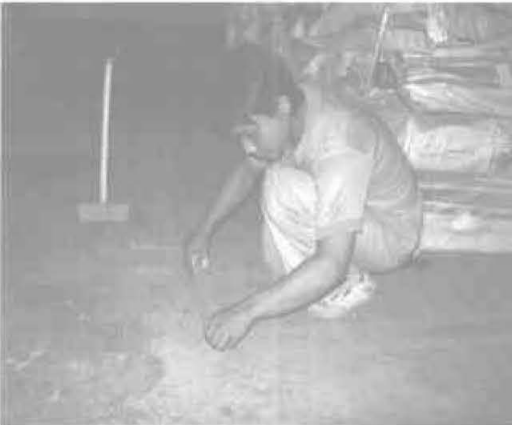
Gambar 34 Karyawan mulai memasang lakban di blok I
